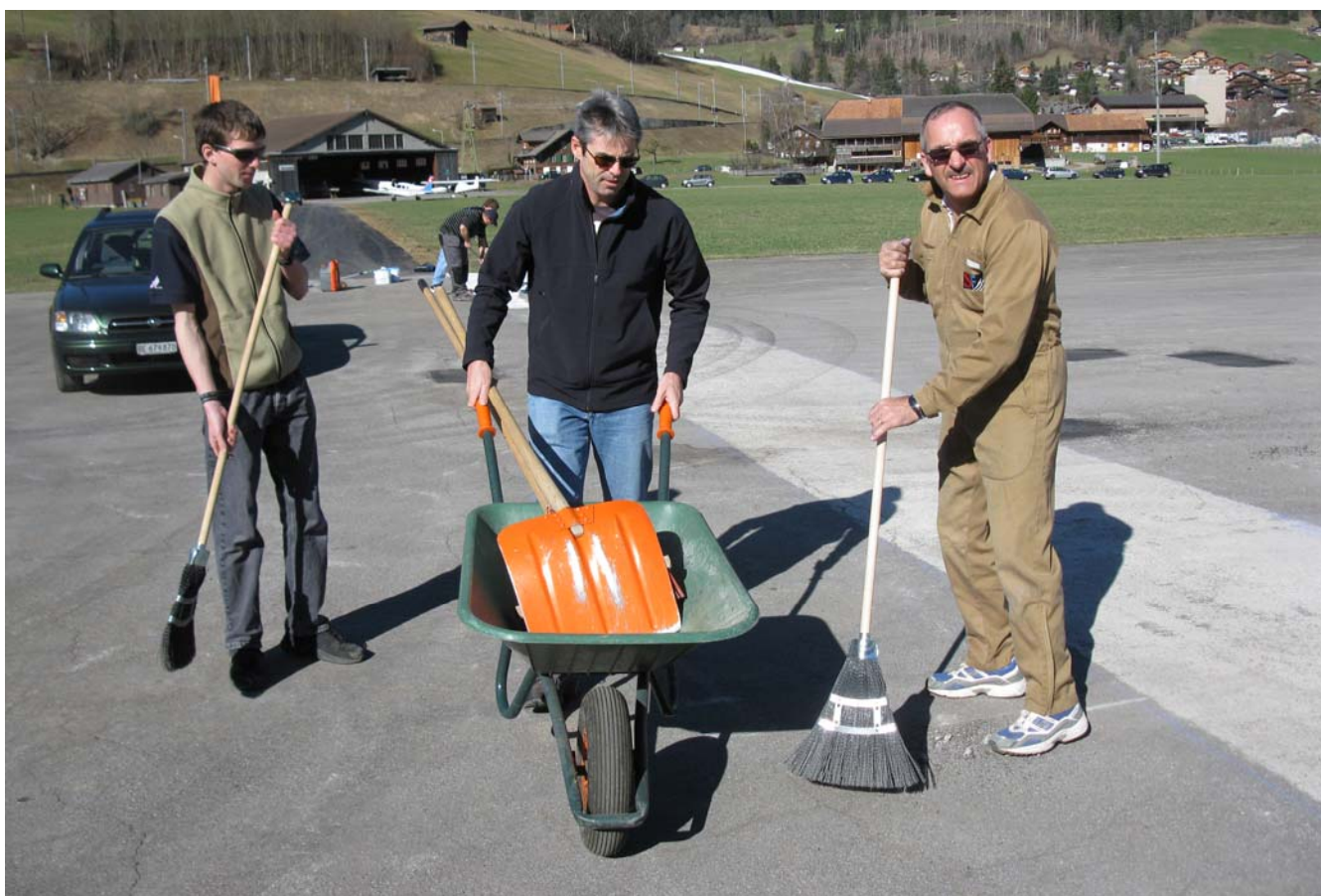
Unterhaltsarbeiten am Flugplatz
